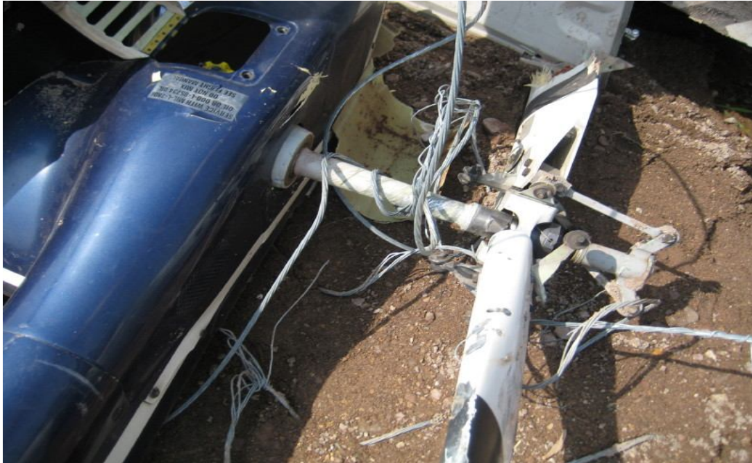
CABLE ENREDADO EN ROTOR DE COLA
